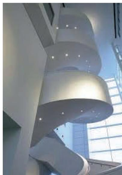
Le lastre Flexy sono impiegate per la realizzazione di superfici curve in pareti, contropareti e controsoffitti.
